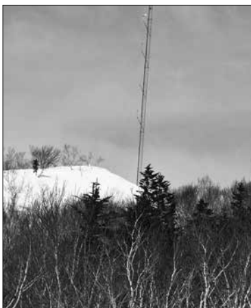
上紋峠近くの藻瀬狩山に設置された風況調査の観測塔
