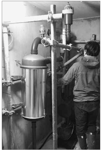
90坪ほどの倉庫兼育苗ハウスを牛房や生乳処理室に改修
