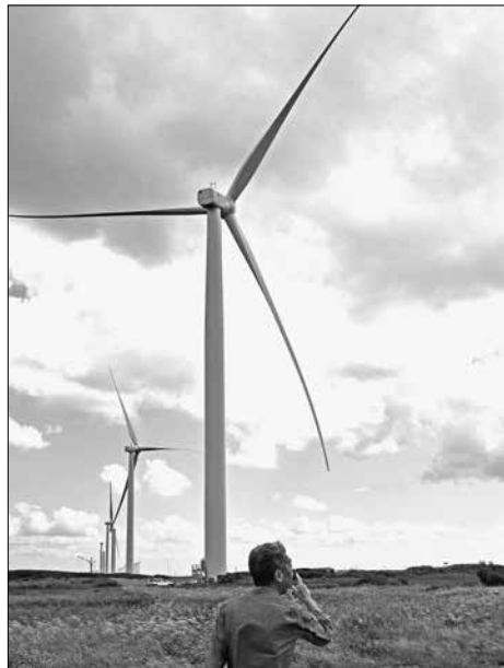
梶延町内の「浜里ウインドファーム」では23年の稼働後、バードストライクが相次ぐ(22年夏撮影)
