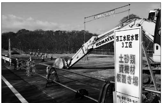
「ラピダス」の工場用水は安平川から取水。美々川の近くでも配水管の工事が進む
