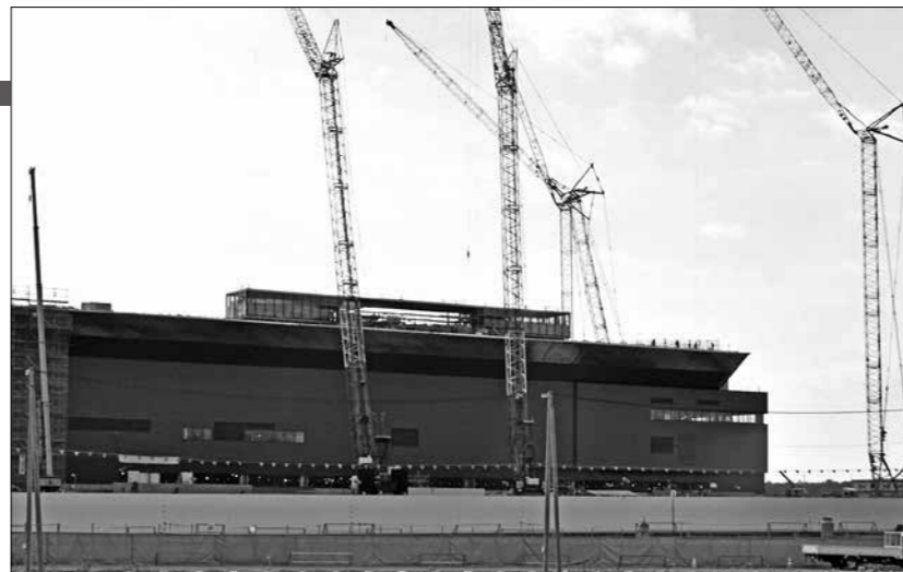
25年の操業開始をめざし急ピッチで建設が進む「ラピダス」の工事現場(10月下旬撮影)
