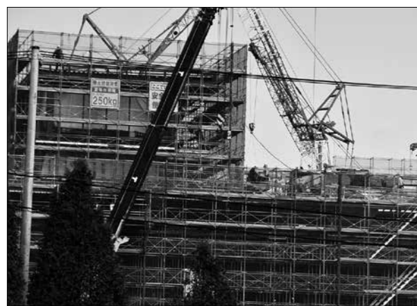
新千歳空港にほど近い「美々ワールド」の一角で急ピッチで進む「ラビダス」の建設現場
