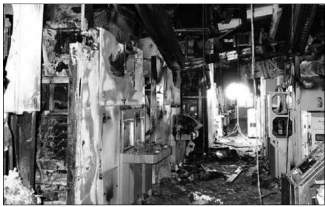
21年3月、茨城県内の半導体工場で発生した火災の現場(さっぽろ自由学校「遊」半導体講座の資料から)
