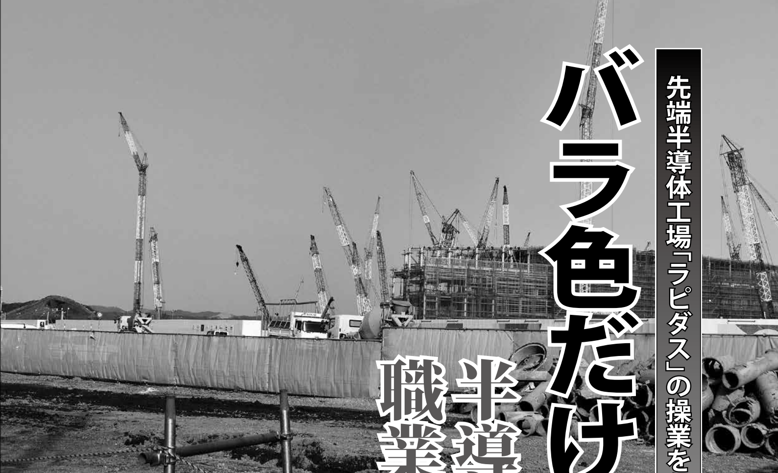
2025年の操業をめざす国産先端半導体の製造工場「ラピダス」の建設現場(千歳市美々)。急ピッチで工事が進むが、製造に伴う負の影響について、道民に対する十分な情報提供はなされないままだ
