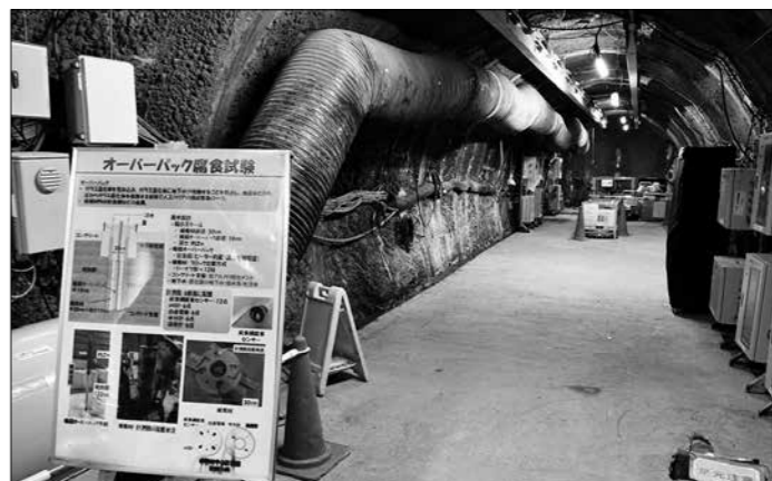
幌延深地層研究センターの350m調査坑道。核のゴミを模した物体を埋め、地下環境への影響などを調べてきた(21年4月撮影)
