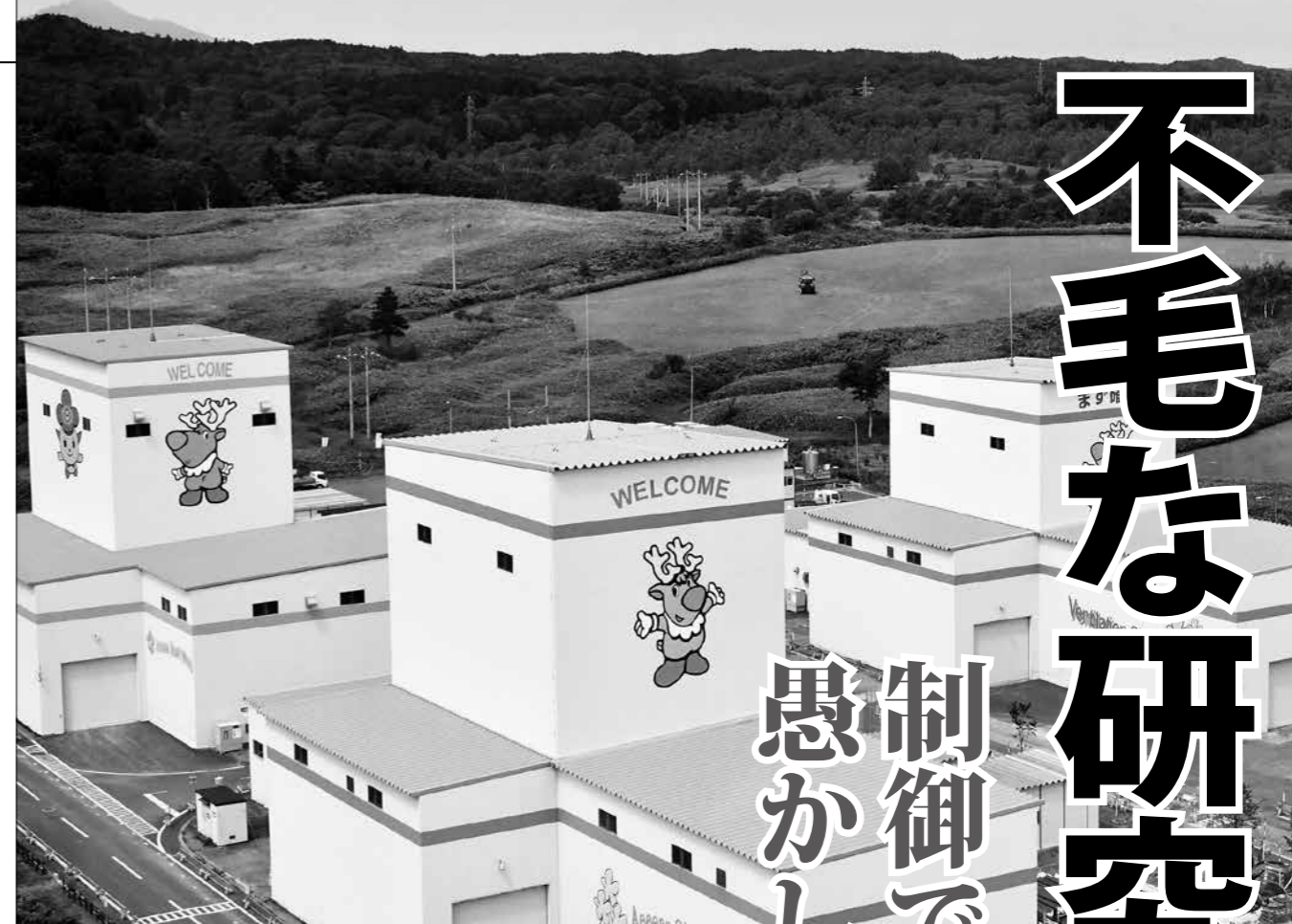
幌延深地層研究センターの展望台から見た立坑の建屋。新たに500メートルまで坑道を掘削する場合、現在より厳しい地下環境での試験になるため、災害や事故の危険性が増し、研究の長期化は必至だ。「28年度末の研究終了」の約束は再び反故にされかねない
