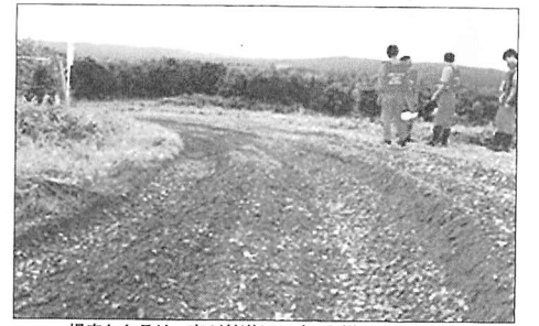
爆走したラリー車が林道につくった轍。完全に修復するのは難しい(十勝自然保護協会のHPより)
