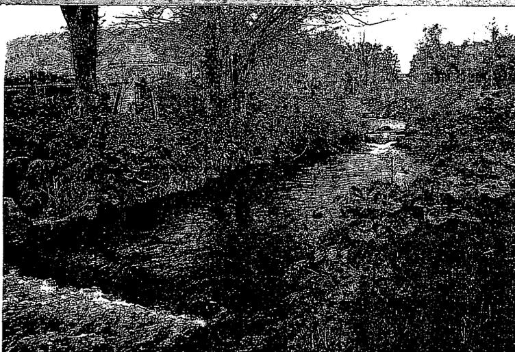
見直しの工事が行なわれた後、川は少しずつかつての面影を取り戻しつつある。湖の下流には産卵に適した浅瀬が形成されている(写真上)。川の中央部に置いた石の下流に土砂が堆積し、中洲が形成されている。植物が自然に生え、違和感のない復元が進んでいる。周囲には産卵に適した場所も形成されていた(写真下)
