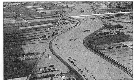
81年の洪水時の千歳川下流部（上方が石狩川。開発局発行「水害」より）
