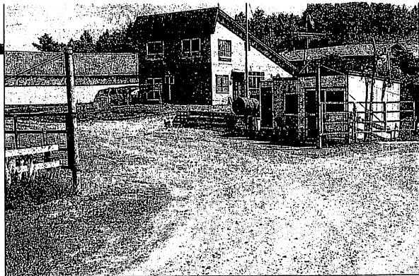
「貯蔵工学センターは白紙」と言いつつ、写真右のプレハブでは警備が続く(幌延町開進で)
