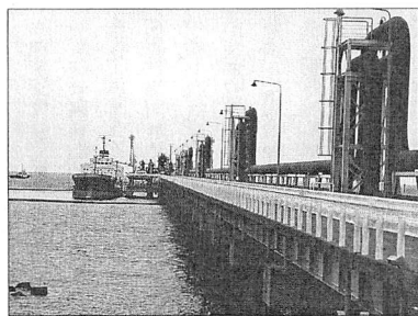
知内火力の揚油棧橋。重油用とオリマルジョン用の2本の輸送管が走る
